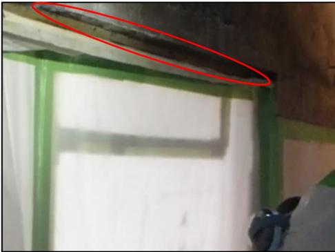
図4.15.6 コンクリート梁の下端に石綿が残っている例
