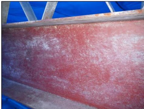
図4.15.4 除去面に再付着し残っている石綿の例
