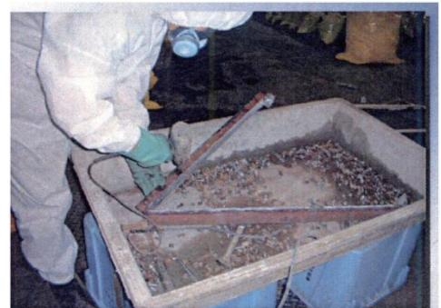
図4.11.17 搾き落とし除去作業の例
