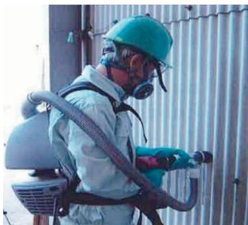
図4.11.7 機械工具による切断例
