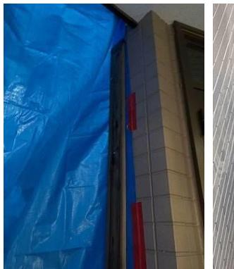
③外壁とシートを角材で固定。 ④下屋の端部での隔離養生のシートの反対側は足場のシート等と繋ぐ。
