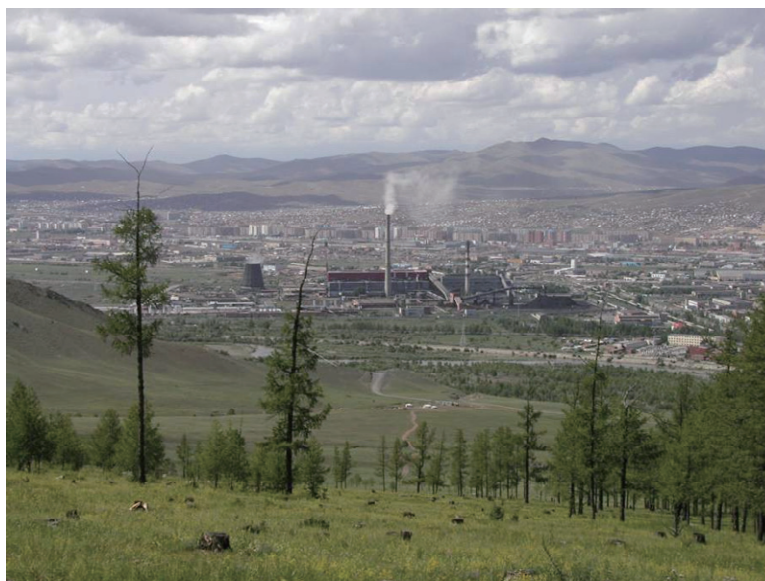
図 3-4-2-2 モンゴルウランバートル近郊のボグドカーン山のカラマツ枯損 正面は、ウランバートル第 3 火力発電所
