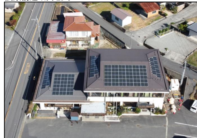
農業構造改善センター
