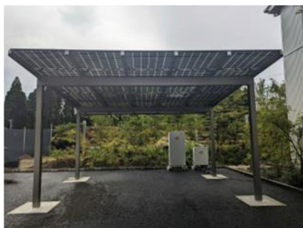
【カーポート架台】
