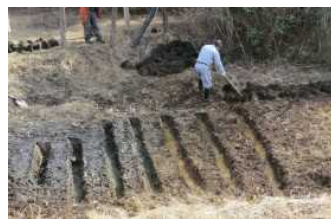
土砂堆積部分の浚渫
