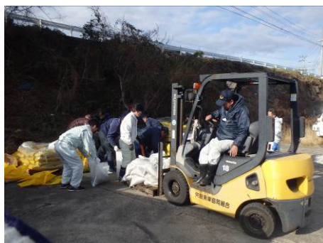
土嚢の運搬状況
