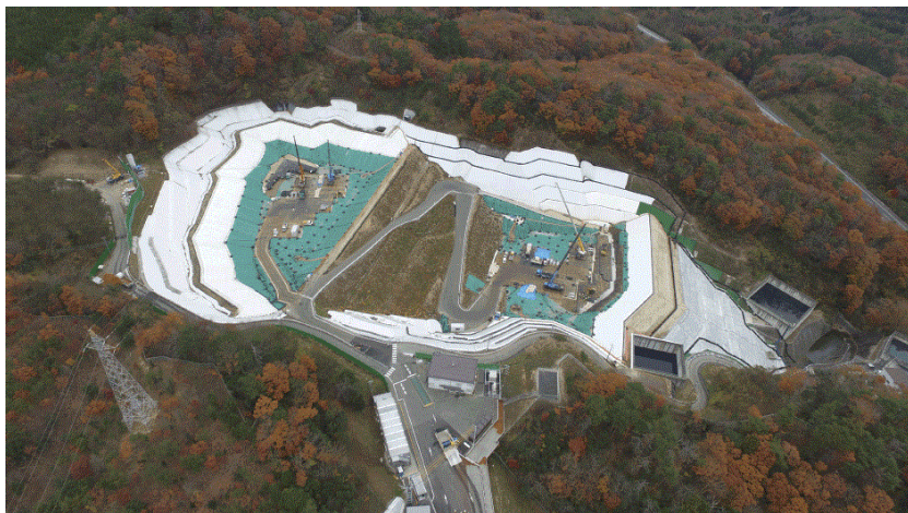
管理型処分場の様子
