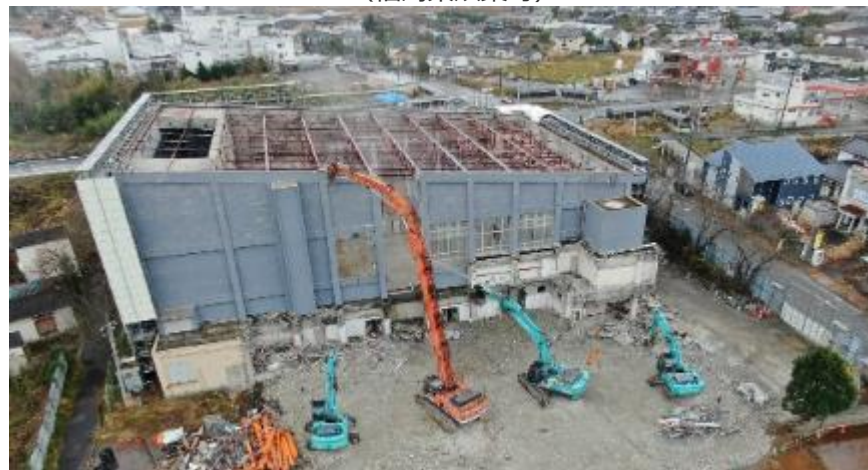
特定復興再生拠点区域での解体工事の様子 (福島県双葉町)
