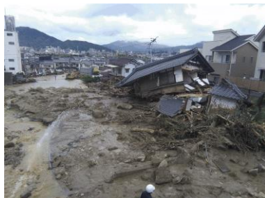
平成30年7月豪雨の被害の様子
