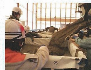
セメント固化剤の注入
