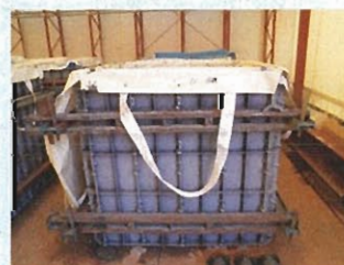
型枠のセット状況
