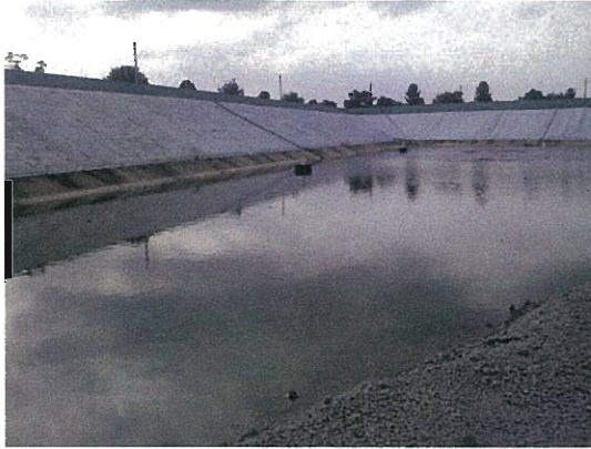
図 浸水している処分場
