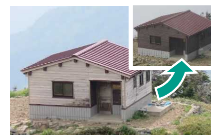
避難小屋の外壁塗装による長寿命化対策 (白山)
