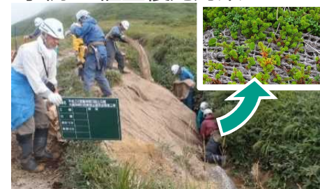
緑化による法面崩壊防止 (磐梯朝日 朝日連峰)
