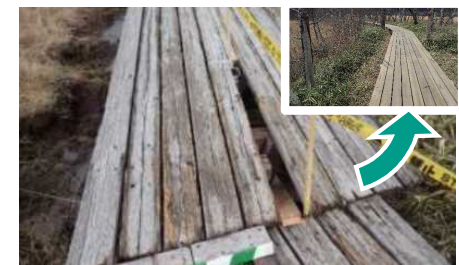
老朽化木道の改修 (日光 戦場ヶ原)
