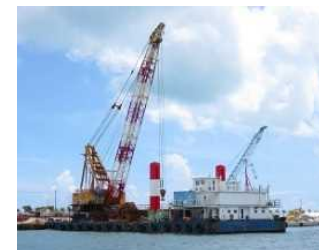
施工クレーン台船
