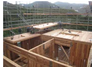
CLTを用いた施工例
