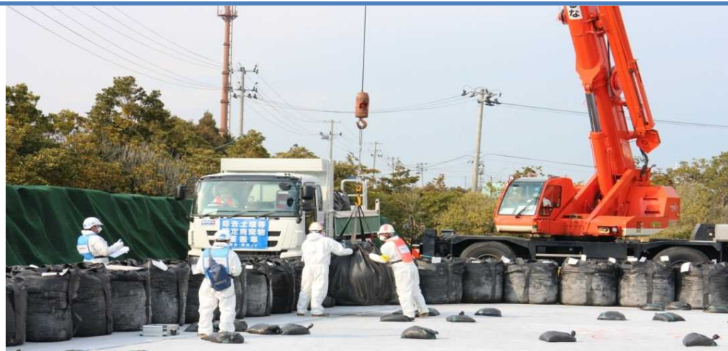
保管場への搬入・定置作業
