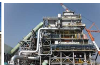
浪江町の仮設焼却施設 (平成27年4月)
