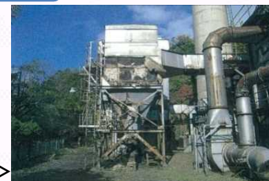
老朽化した廃棄物処理施設の更新
