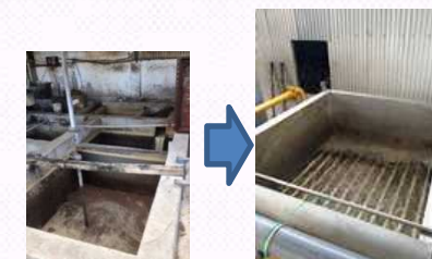
既存の排水処理槽
