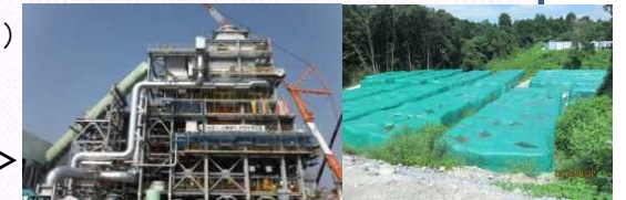
仮設焼却炉の建設状況 (対策地域内廃棄物)
