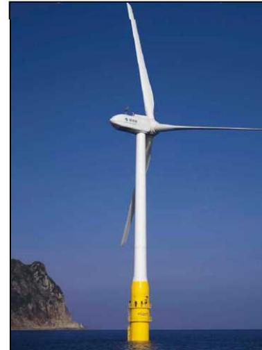
国内初2MW浮体式洋上風力発電機
