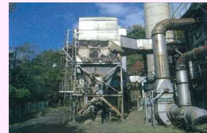
老朽化した廃棄物処理施設の更新
