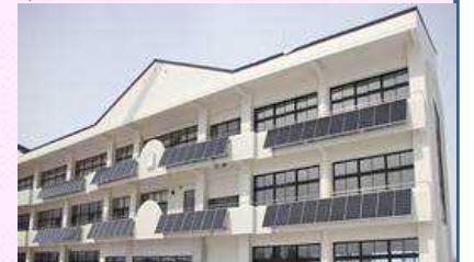
学校への太陽光発電施設の導入
