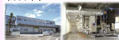
冷凍倉庫用の自然冷媒冷凍機
