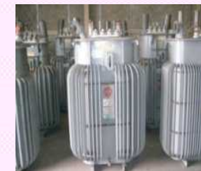
PCBが含まれる高圧トランス
