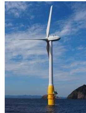
商用スケール実証機 [H25年10月に運転開始]
