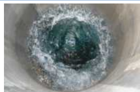
(熊本市) 水道水源井戸
