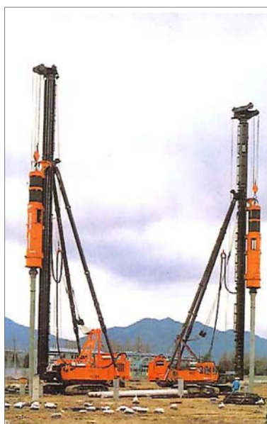
油圧パイルハンマによる作業
