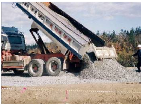
ダンプトラックによる路盤材料搬入状況
