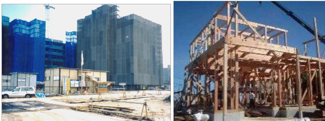
施工状況の全景
