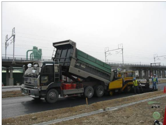
アスファルトフィニッシャによる舗装作業
