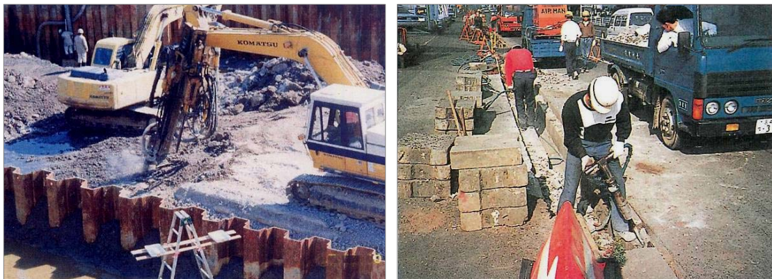
パワースプリッターによる取り壊し作業
