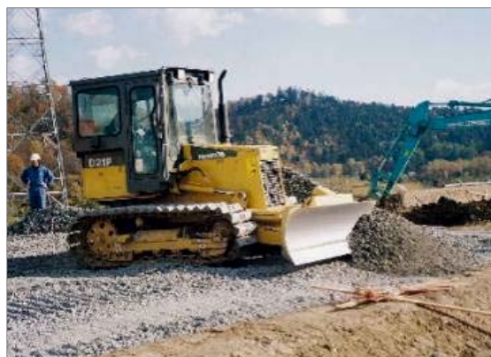
ブルドーザによる敷均し作業
