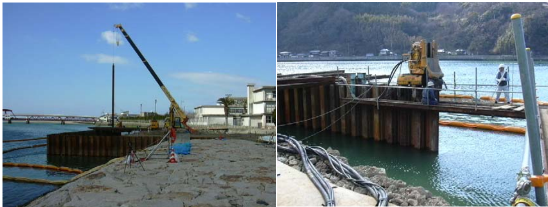
油圧式圧入引抜機による圧入作業
