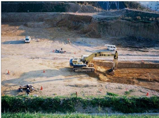
バックホウによる掘削
