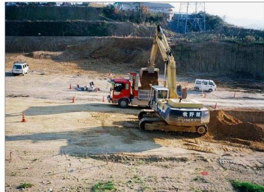
積み込み作業
