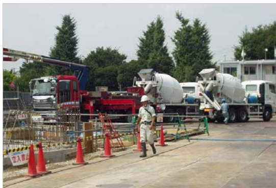
施工状況の全景
