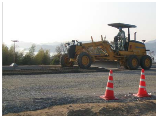
モータグレーダによる敷均し作業
