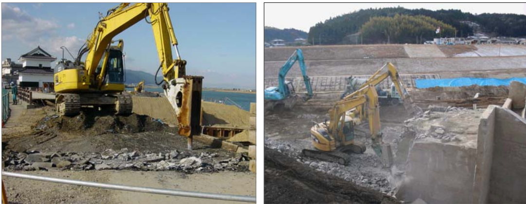
大型ブレーカーによる取り壊し作業
