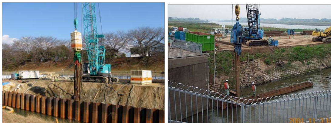
バイブロハンマによる鋼矢板打込み作業
