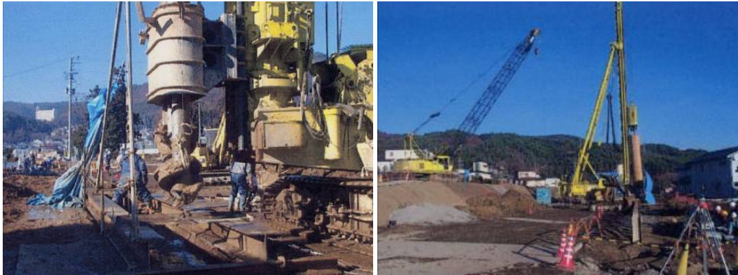
掘削機による掘削作業
