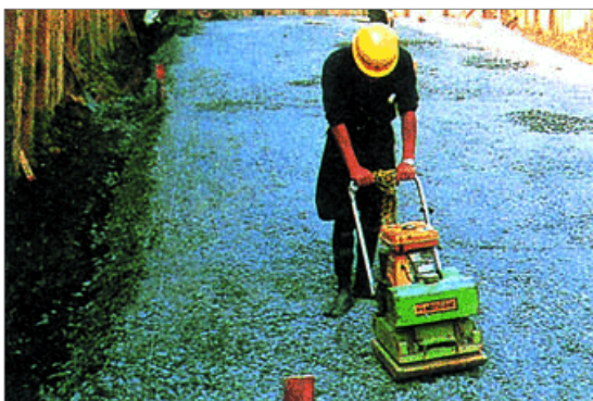
振動コンパクタによる作業
