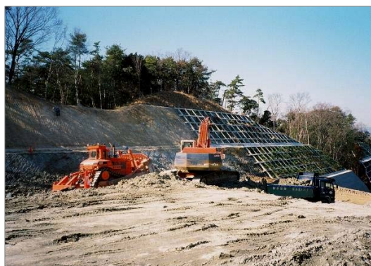
ブルドーザのリッパ掘削とバックホウによる掘削・積み込み作業
