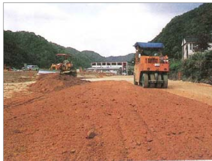
ブルドーザによる敷均し、タイヤローラによる締固め作業
