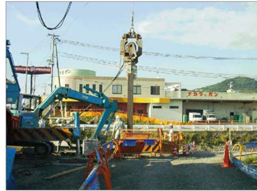
H形鋼挿入作業
