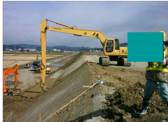
バックホウによる盛土法面整形作業
