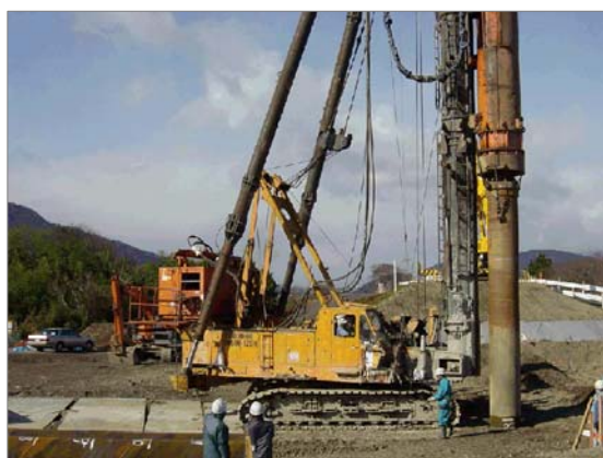
油圧ハンマによる作業
