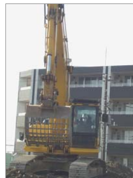
スケルトンバケットによる分別作業
