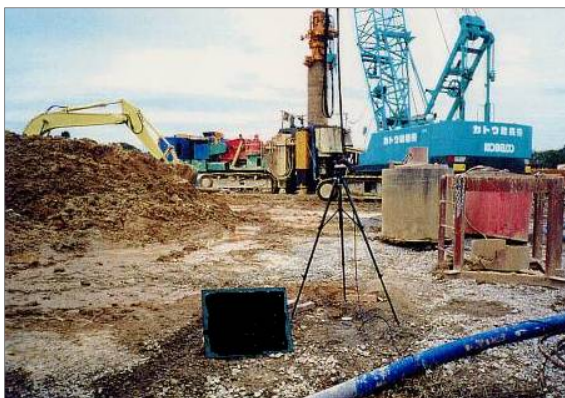
施工状況の全景
