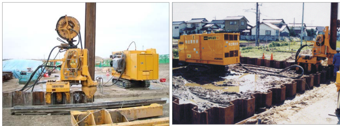
油圧式圧入引抜機による圧入作業(打ち込み部と本体)
