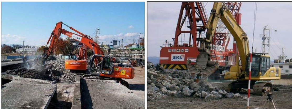
コンクリート圧砕機による桁破碎作業
