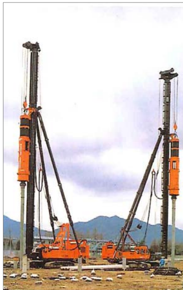
油圧パイルハンマによる作業
