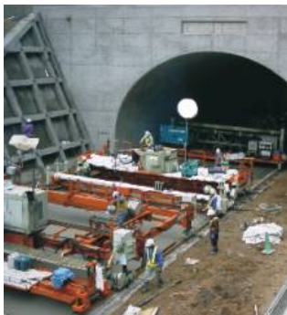
施工状況の全景
