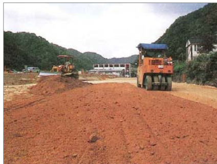
ブルドーザによる敷均し、タイヤローラによる締固め作業
