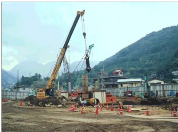
ハンマーグラブによる掘削作業
