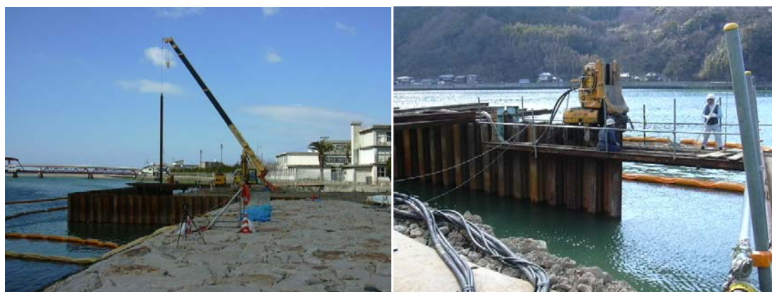
油圧式圧入引抜機による圧入作業
