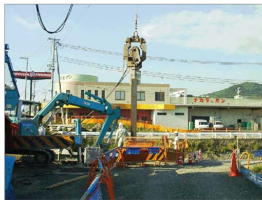
H形鋼挿入作業
