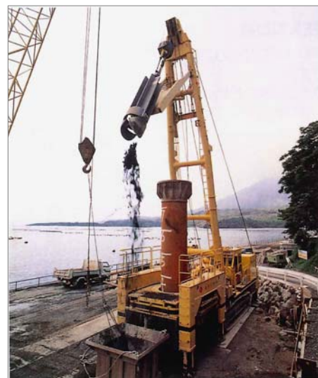
オールケーシング掘削機による作業
