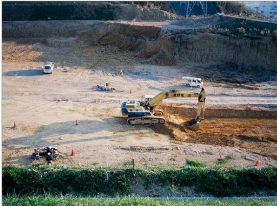
バックホウによる掘削
