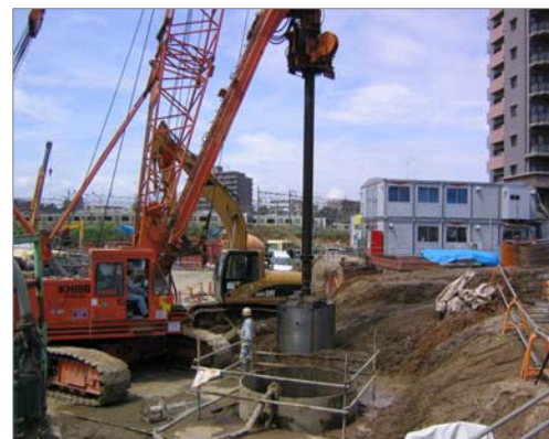
アースドリル掘削機による掘削作業
