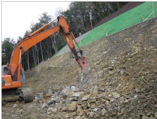
ブレーカーによる切土法面整形作業
