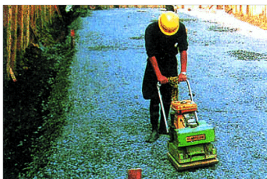
振動コンパクタによる作業
