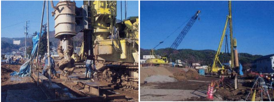
掘削機による掘削作業
