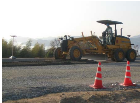
モータグレーダによる敷均し作業
