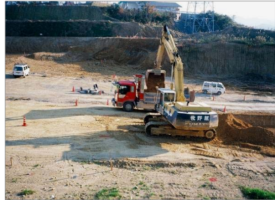
積み込み作業
