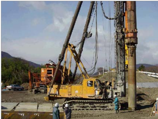
油圧ハンマによる作業
