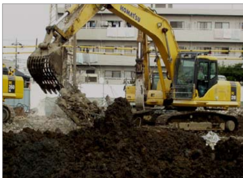
スケルトンバケットによる分別作業
