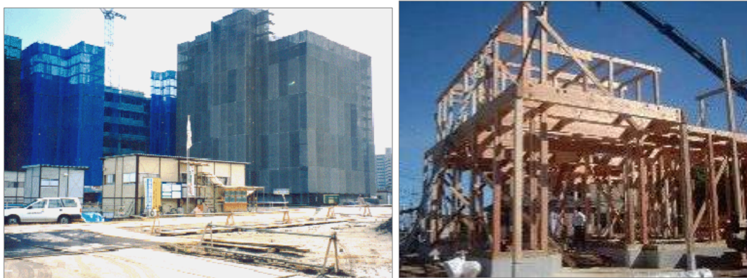
施工状況の全景
