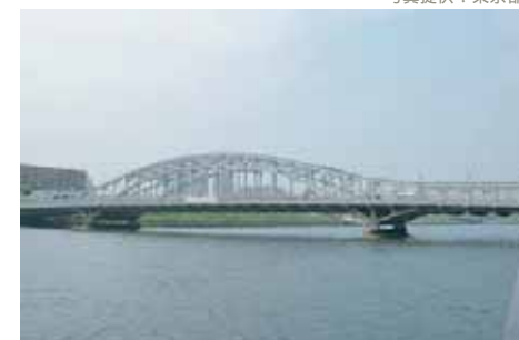
低VOC塗料で塗り替えられることになった白鬚橋(墨田区)
