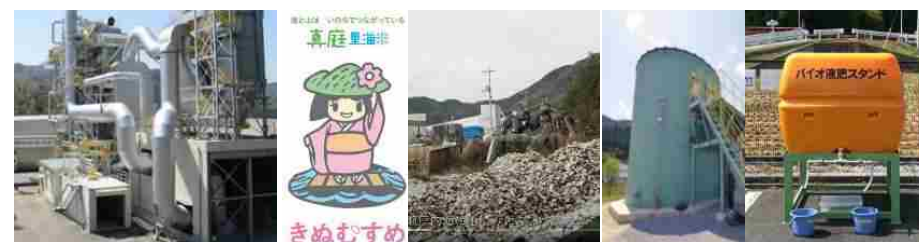
木質バイオマス発電施設
