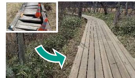
老朽化木道の改修
