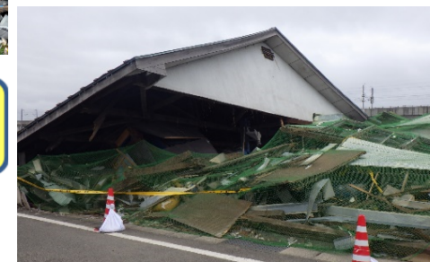
②損壊した家屋等の解体、がれきの収集・運搬及び処分
