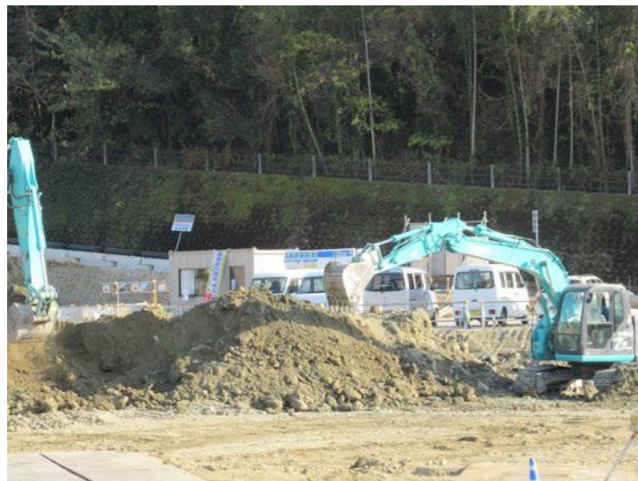
搬出区域における自然由来等土壌の掘削 (搬出)
