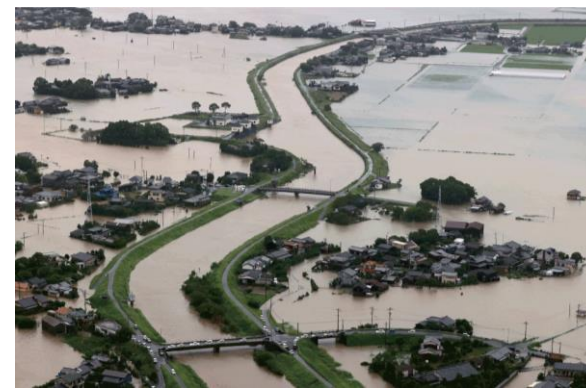
令和3年8月の大雨の被害の様子
