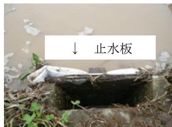
止水板の設置
