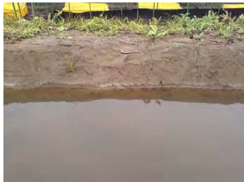
図 II-10. 土壤硬化剤を施した畦畔区
