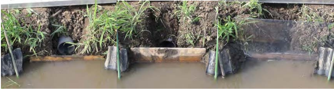
図 II-28. 水尻排水口の止水構造 (左から木製の止水板、高めの止水板、アクリル板を加えた 2 重の止水)
