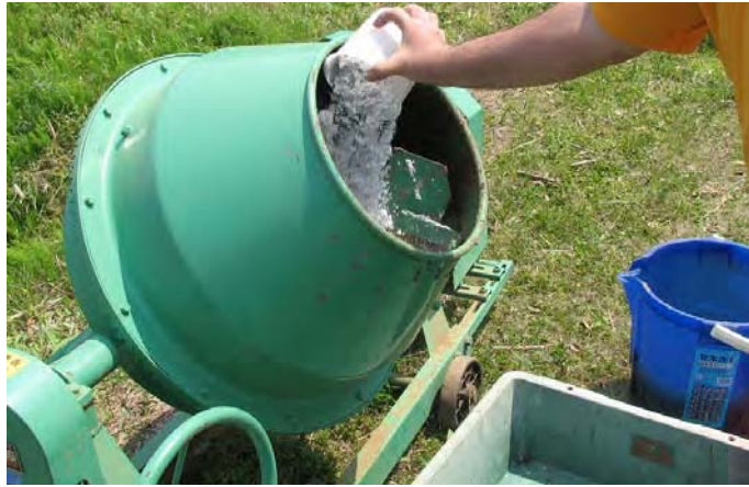
図 II-7. 土壤硬化剤をコンクリートミキサーに入れて土壌と混和しているところ
