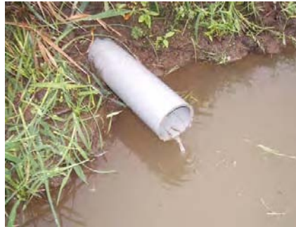
図 II-29. 水尻排水口からの漏水
