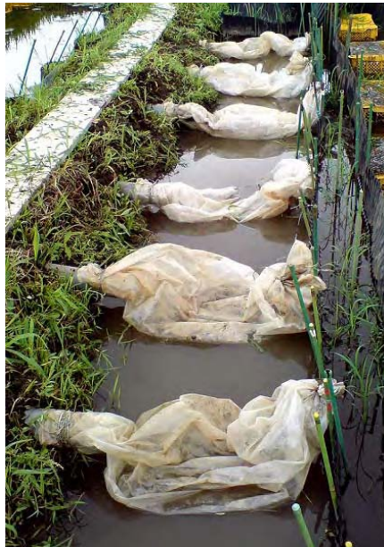
図 II-30. 漏水を捕捉するためのポリ袋
