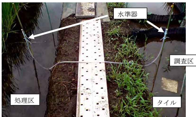
図 II-20. 簡易水準器と水深計測用タイルの設置(2回目試験)
