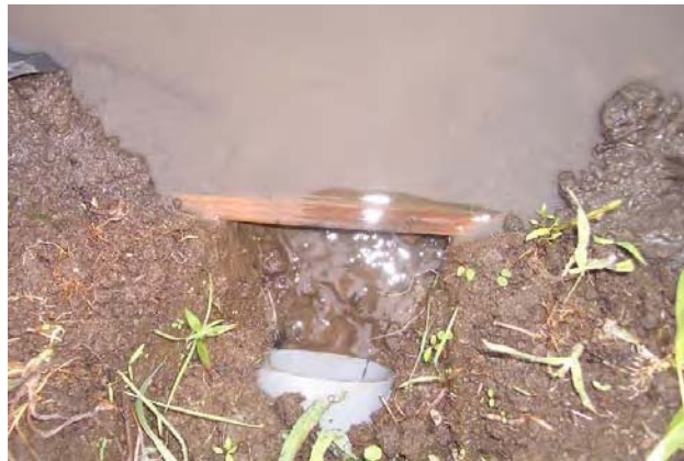
図 II-35. 大量降雨後の対照止水板(A 区)における溢水の状況
