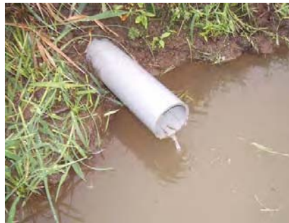
図 II-29. 水尻排水口からの漏水
