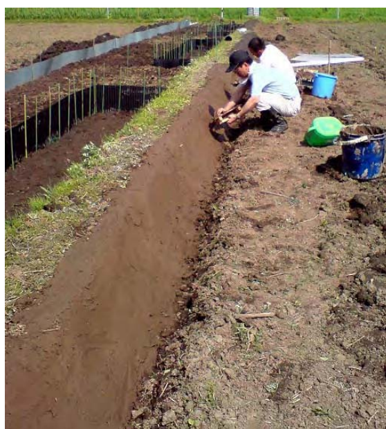
図 II-8. 土壌硬化剤を混和した土壌を畦畔に塗り付けているところ
