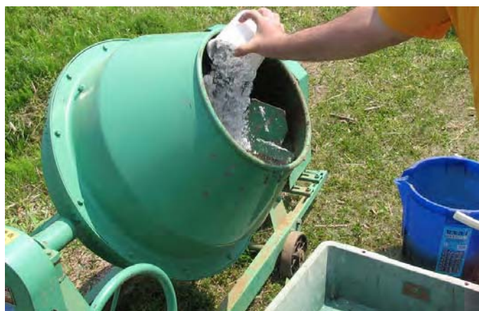
図 II-7. 土壌硬化剤をコンクリートミキサーに入れて土壌と混和しているところ
