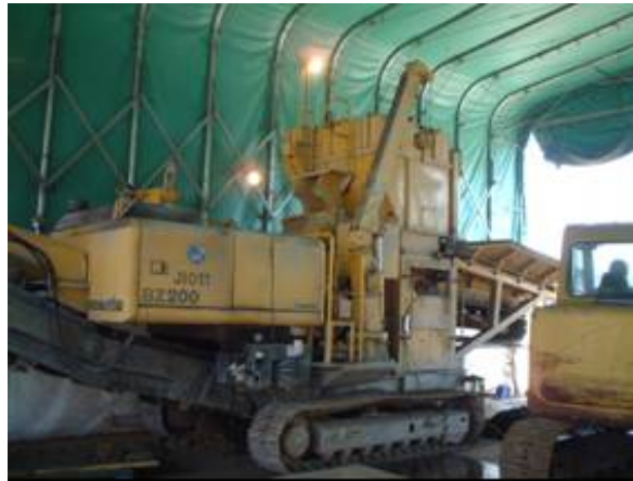
写真4 生石灰混合処理の混合作業の例 出典 (3)
