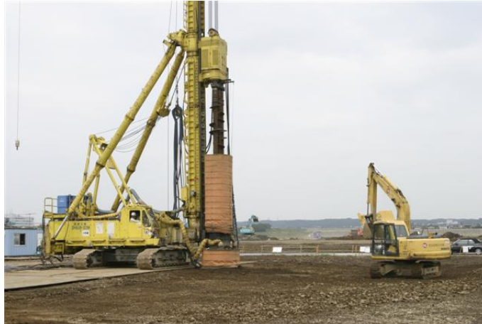
写真1 オーガーによる鉄粉混合の例 出典 (3)
