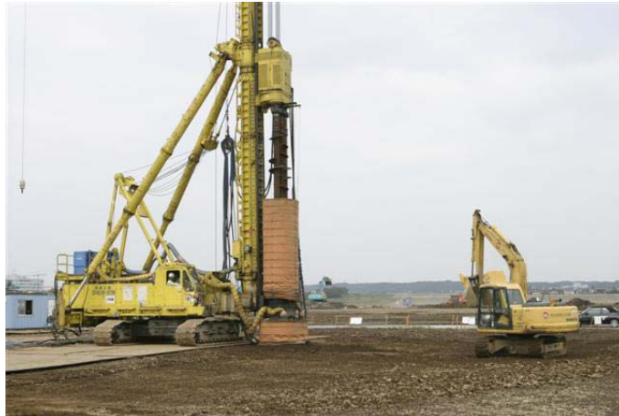
写真1 オーガーによる鉄粉混合の例 出典(3)
