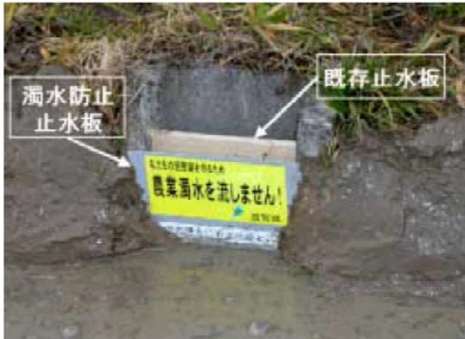
写真 III - 6 濁水防止止水板の設置
