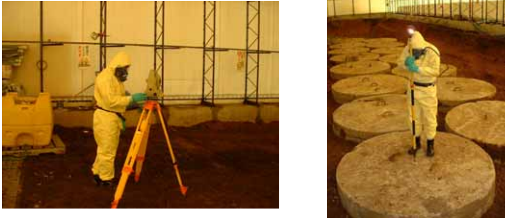
図 4.2.2 トータルステーションによるヒューム管の位置測量状況
