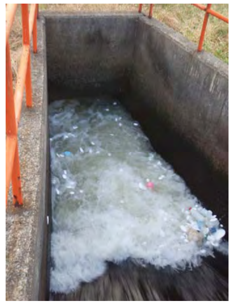
調査前の高坂サイホン施設
