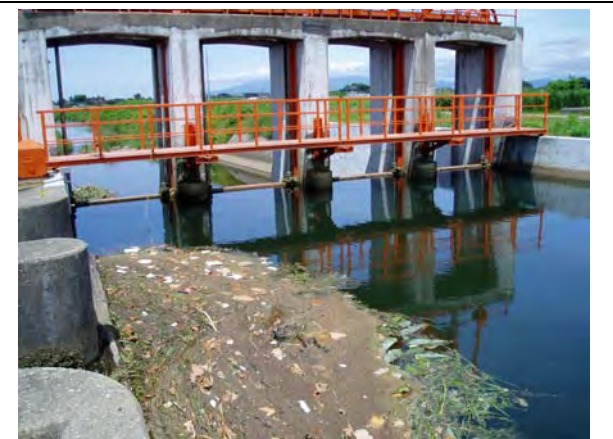
調査前の湯野沢分水工(2010.6)
