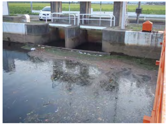
調査前の湯野沢分水工
