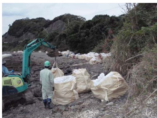
重機による回収・搬出(第1回調査)
