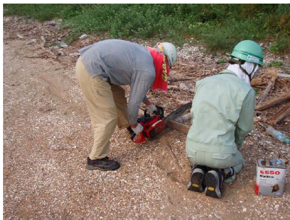
チェーンソーによる流木切断作業
