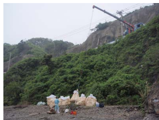
10t ユニック車による回収(第5回調査)
