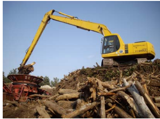
破碎処理プラント
