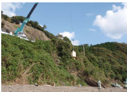
16t クレーンによる回収(第1回調査)
