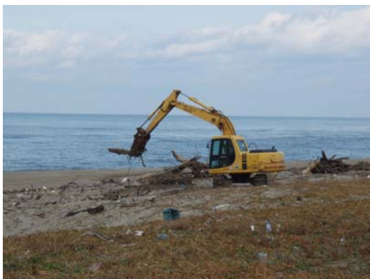
バックホウによる回収（第4回調査）
