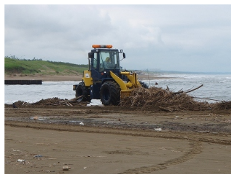
レーキドーザによる回収（第5回調査）
