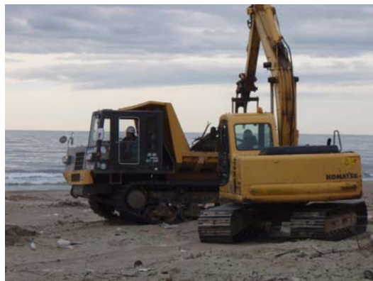
バックホウによる回収（第4回調査）
