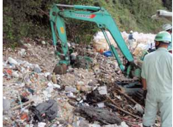
重機による回収(第1回調査:発泡スチロール)
