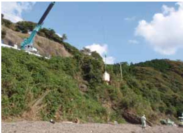
16t クレーンによる回収
