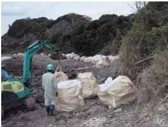
重機による回収・運搬
