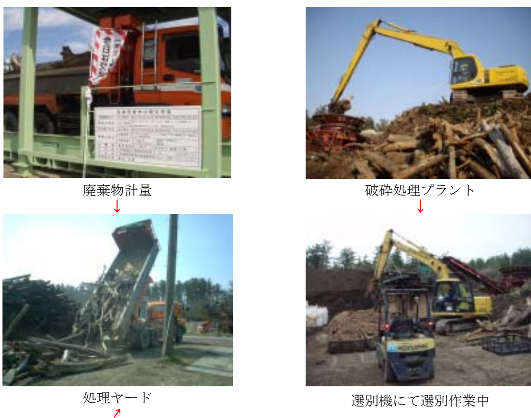
図 3.2-38 流木の中間処理風景
