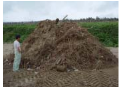
レーキドーザによって集められたゴミ 人力による分別が必要(第5回調査(2008年7月))
