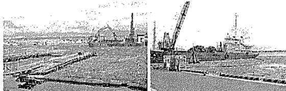
図 8 バックホウ台船（左）とガット船（右）による撤去状況
