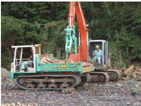
不整地車両への積み込み（樋島海岸）
