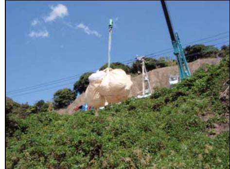
クレーンによる運搬（志多留海岸）
