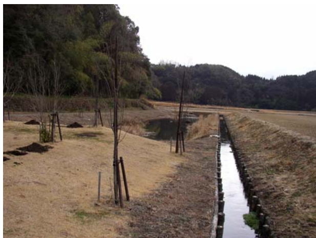
幹線の途中にため池をつくっている
