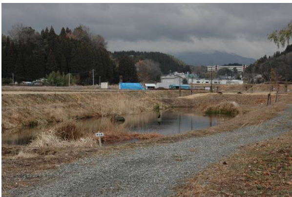
幹線の途中にため池をつくっている
