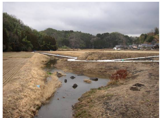
排水路（旧玉来川の一部）
