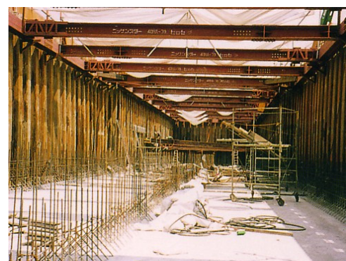
第1号公園(おかげ公園)地下に設置されている雨水貯留施設
