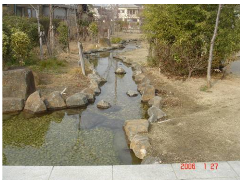
第1号公園(おかげ公園)内のせせらぎ(おかげ水路)
