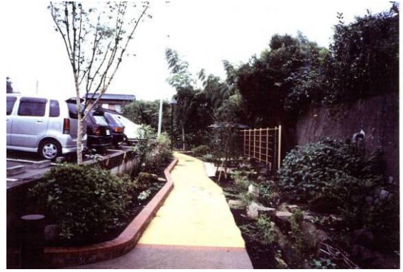
C 工区整備後
