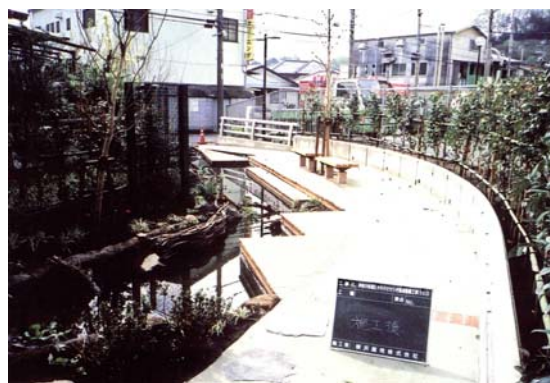
B工区整備後
