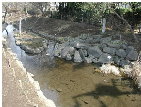
中流親水散策ゾーンとの循環水吐出口
