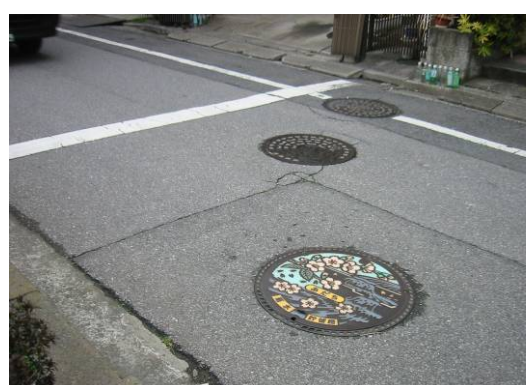
手前が貯留水路、奥が雨水柵のマンホール
