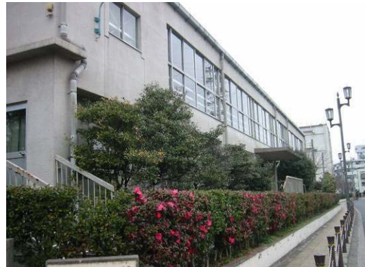
体育館の屋上に降った水は樋を通して地下の雨水枿を経て雨水貯留槽へ流れる
