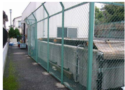
浄化設備では水を砂ろ過によって浄化する
