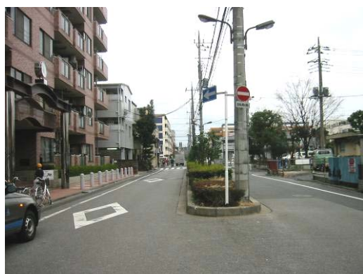
左側道路の下に貯留水路がある
