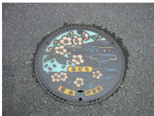
雨水貯留（一時貯留）槽のマンホール
