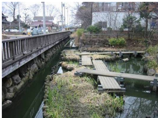
葛西用水親水水路の上流端付近。最上流部では水生生物による浄化も行っている
