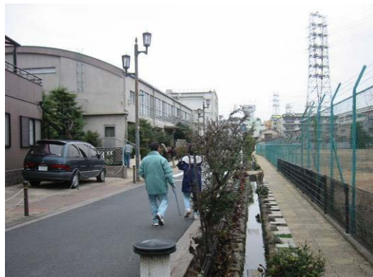
竜井堀親水水路：左手の学校の体育館及び校舎屋根に降った雨水を水源とする
