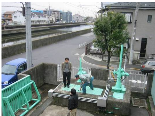
左上の流れが水源の花畑川。花見橋水門管理所の樋管を利用し取水している (干潮時はポンプアップ)
