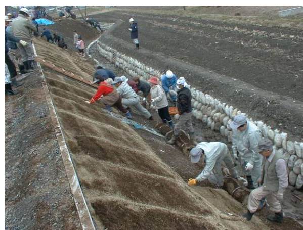
法面の植生マット（芝）張り作業
