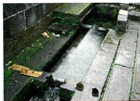
写真 1 住民により清掃された湧水
