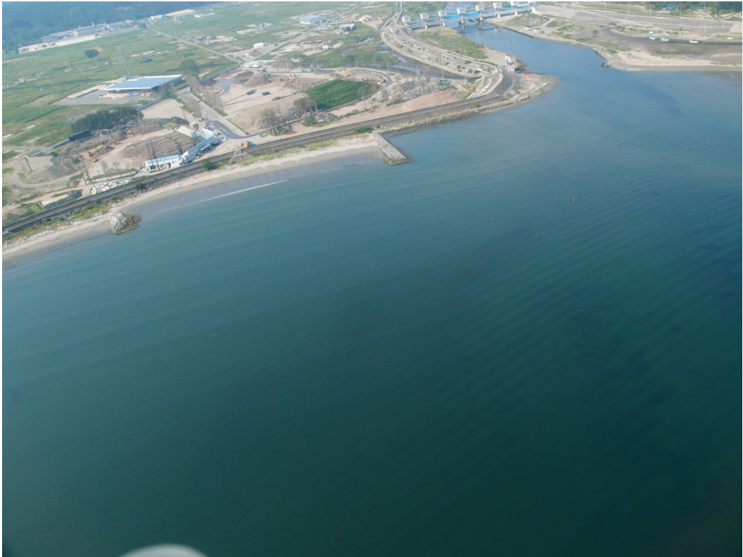
写真 3-2-3 津軽石川右岸河口
